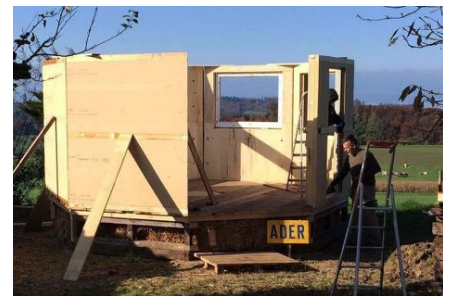
Les parois sont montées
