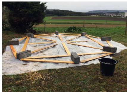
Mise à niveau du terrain
